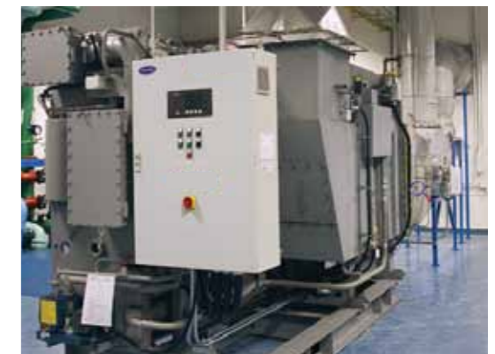
Las microturbinas (arriba) y el absorbedor (abajo) se integran para crear la solución.
